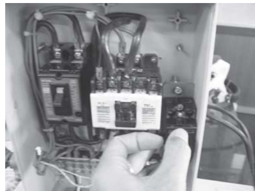
รูปที่ 3 ติดตั้งเซอร์กิตเบรกเกอร์เพื่อเลือกระบบ
