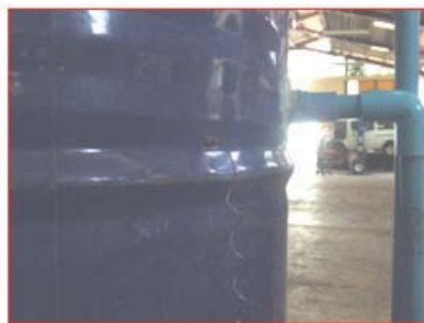
รูปที่ 3 การติดตั้งเครื่องมือวัดควบคุมอุณหภูมิน้ำถึงระบายความร้อน
