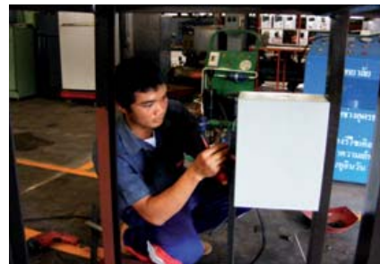
รูปที่ 4 ติดตั้งอุปกรณ์ไฟฟ้าและอุปกรณ์ควบคุม
