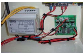
รูปที่ 10 แสดงการติดตั้งชุดควบคุม 2
