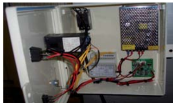
รูปที่ 9 แสดงการติดตั้งชุดควบคุม 1
