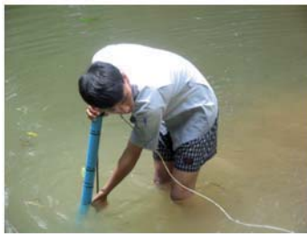
รูปที่ 8 การติดตั้ง อุปกรณ์ตรวจวัดระดับน้ำ บริเวณต้นน้ำของน้ำตกวังมะเดื่อ
