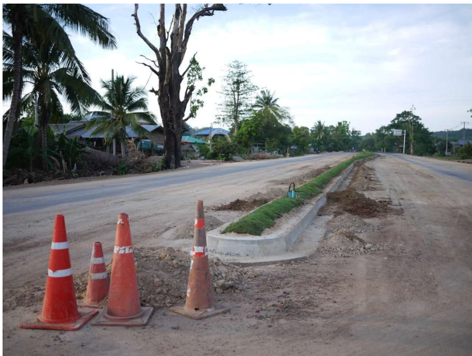
ถนนบริเวณบ้านภูมิซรอล ขยายใหญ่ขึ้นรองรับการเดินทางบริเวณชายแดนไทยกัมพูชา สภาพถนนกำลังปรับปรุงสร้างใหม่
