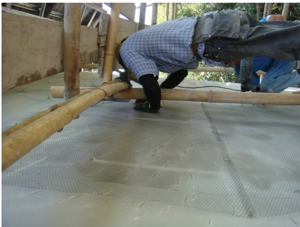
ยึดตะแกรงเหล็กฉีกด้วยสลักเกลียว
