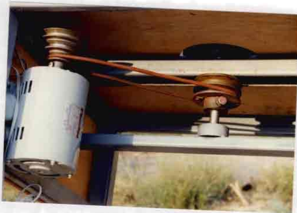
ภาพที่ 48. แสดงการติดตั้งมอเตอร์
