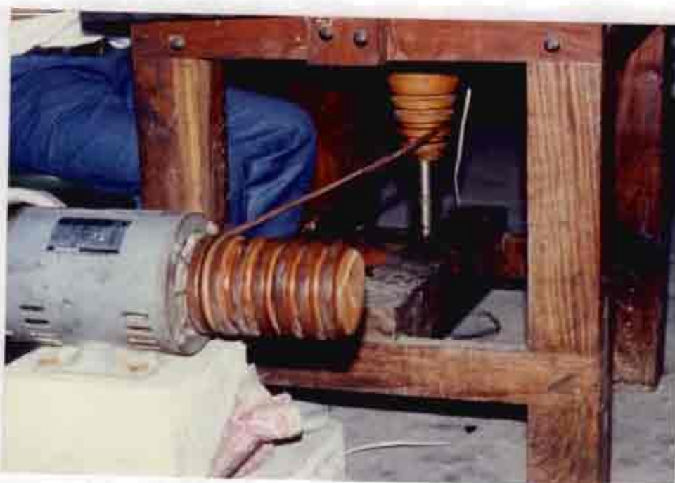
ภาพที่ 47 แสดงการติดตั้งสายพานและพูลเลย์
