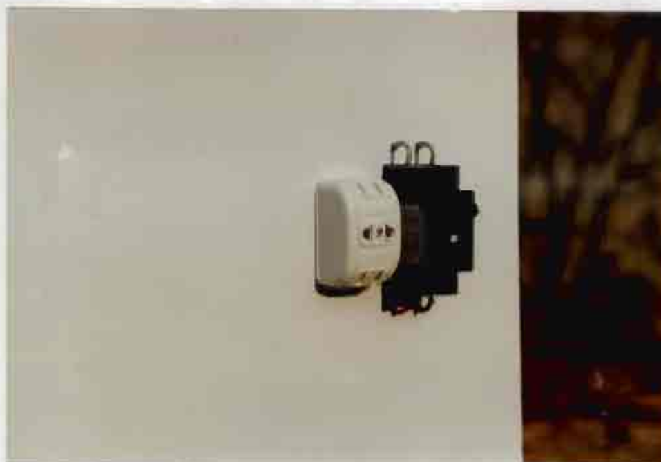
ภาพที่ 41 แสดงการติดตั้งสวิตช์อัตโนมัติที่ตัวเครื่องสำหรับตัดตัวจักรเจียร์ในพลอย พัฒนา
