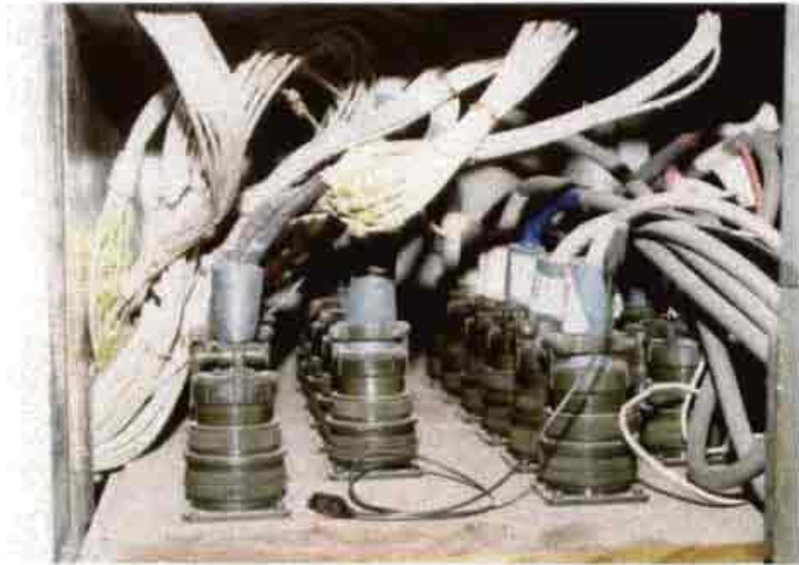
รูปที่ 6.3 แสดงลักษณะของแผ่นทองแดงที่ใช้เป็นจุดเชื่อมต่อระหว่างสาย Thermocouple กับ Compensate Wire
