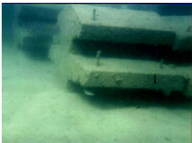
รูปที่ 25. การจมตัวของแท่งซีเมนต์บางกลุ่ม
