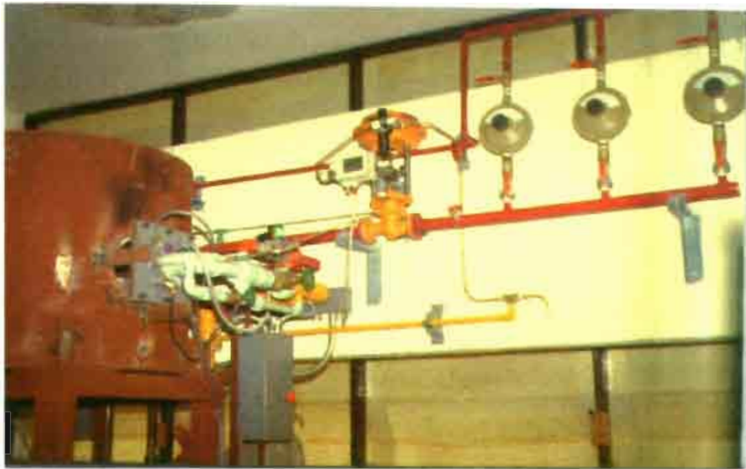
รูปที่ 4.8 แสดงการติดตั้งหัวพัน ไฟและระบบวาล์ว
