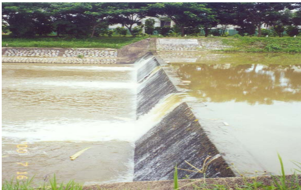
รูปที่ 7 ฝายหนองปلامันซึ่งเป็นฝายคอนกรีต
