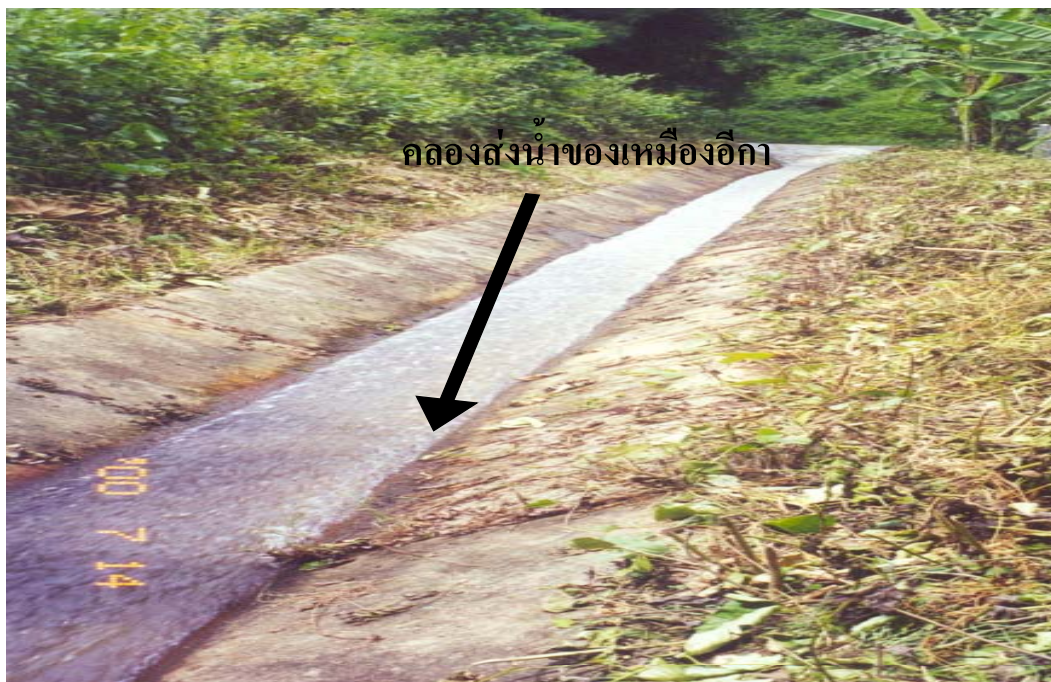
รูปที่ 2 คลองส่งน้ำคอนกรีตของเหมืองอีกา
