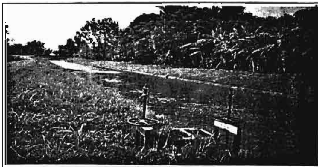
ภาพที่ 3.4 Constant – Head Orifice (CHO)
