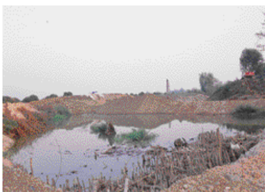
ฝายน้ำบ่อทิพย์แหล่งน้ำที่จะผันเข้าสู่เหมือง
