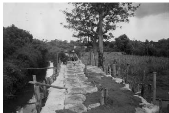
ชาวนาคำนวณกำลังน้ำแล้ววางหลักตีฝาย วางกระสอบทรายชะลอความแรงของน้ำ
