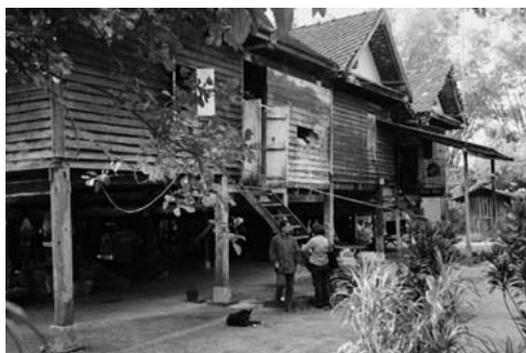
บ้านหลังนี้และเกือบทุกหลังที่มีอายุ 20 ปี ขึ้นไป ในไชยาล้วนแต่ทำจากไม้เคี่ยม
