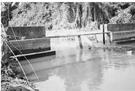
ทำนบป่าไทรงามไม่มีการปิดเปิดน้ำ ช่วงคลองที่สร้างทำนบ มีพื้นที่ต่ำกว่าระดับพื้นที่นาซึ่งเป็นไปไม่ได้ที่จะใช้น้ำ
