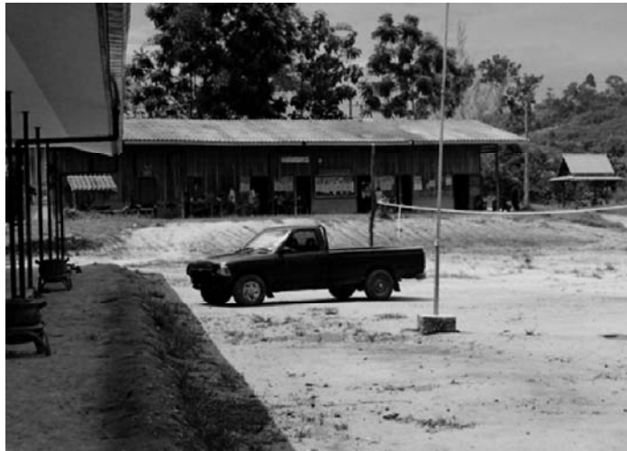
อาคารเรียนหลังเล็ก ร.ร. คลองไม้แดง สร้างด้วยเงินชาวบ้าน และ แรงงานชาวบ้าน
