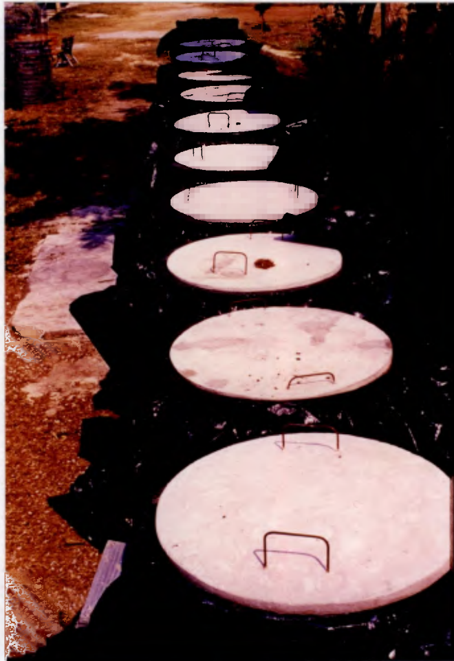
ภาพที่ 9 ปิดไซโลและทับด้วยคอนกรีตเพื่อให้เป็นภาวะไร้อากาศ
