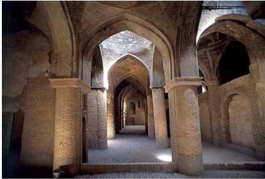
มัสยิดอูมาเมที่อิสฟาฮาน แสดงให้เห็นถึงโครงสร้างอาคารที่ใช้การเรียงอิฐมาประกอบขึ้นเป็นโดม และการเผอิฐให้เกิดสีอ่อนแก่เพื่อสร้างเป็นลวดลาย
