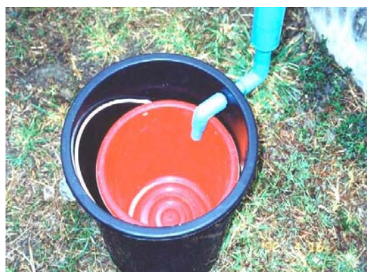
ก.2 ถังเก็บน้ำซึมใต้แปลง
