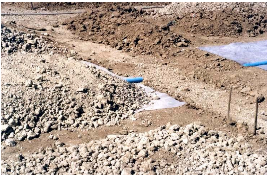
ข. แปลงทดลองระหว่างก่อสร้าง
