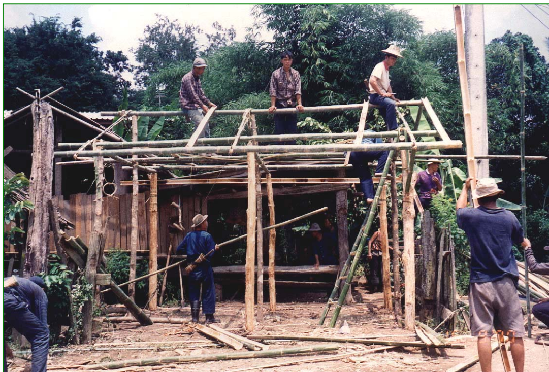
รูปภาพที่ 25-26 ร่วมแรงร่วมใจสร้างร้านค้าท้องถิ่น
