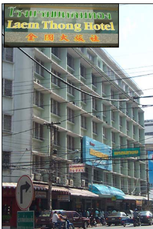
ภาพที่ 65 โรงแรมแหลมทอง โรงแรมเก่าแก่ของหาดใหญ่ บนถนนประชาธิปไตย ตัดกับถนนนิพัทธ์อุทิศ หนึ่ง และ สอง
