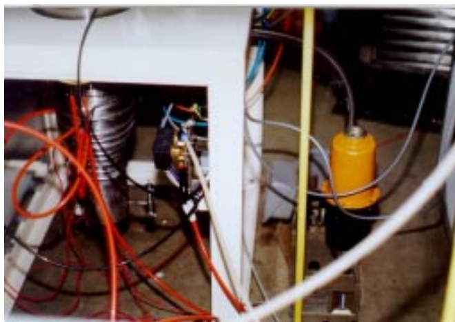
รูปที่ 3.14 การติดตั้งเครื่องสูบบแบบแฟรไอและเครื่องสูบลมโรตารีของเครื่องเคลือบ
