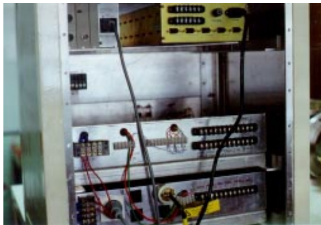
รูปที่ 3.27 การติดตั้งชุดควบคุมการทำงานของเครื่องเคลื่อน
