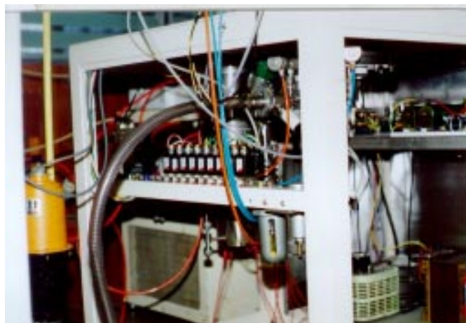
รูปที่ 3.28 การติดตั้งชุดควบคุมมอเตอร์ของเครื่องเคลื่อน
