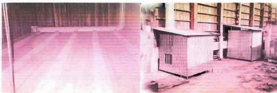
ภาพที่ 10 ระบบเป่าลมในฉางที่ปรับปรุง
