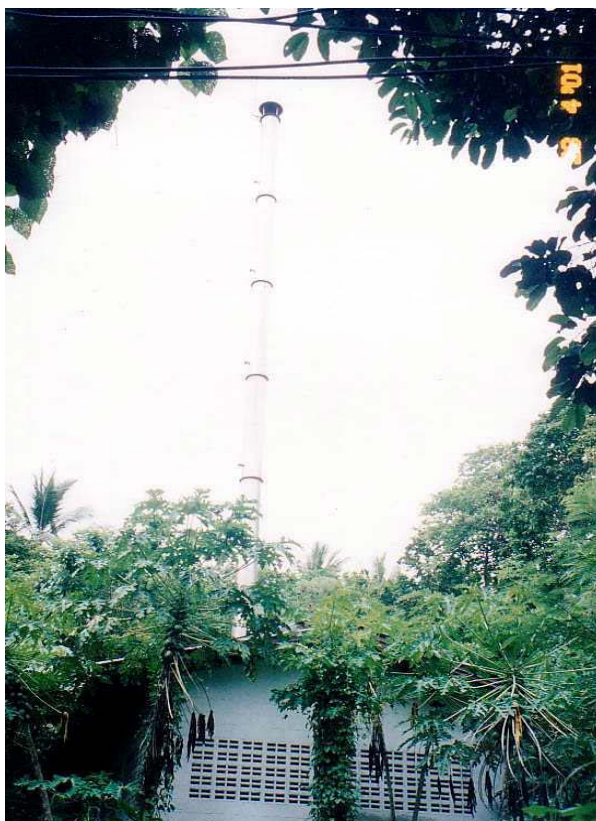
ภาพที่ 8 เตาเผาขยะบนเกาะพีพี จ.กระบี่ ซึ่งถูกทิ้งร้างเพราะไม่มีงบค่าไฟฟ้าเผาขยะ นี่เป็นตัวอย่าง “ปัญหาธรรมชาติบาล” เพราะเทคโนโลยีกับสภาพท้องถิ่นที่ไม่สอดคล้องกัน ทีมนักวิจัยได้มีโอกาสไปดูงานเตาเผาขยะในจังหวัดอื่นๆ ด้วย พบปัญหาคล้ายๆ กันคือ ค่าใช้จ่ายในการเผาขยะแพงมาก ทางกรให้แต่เตาเผามา แต่ไม่ให้ค่าไฟฟ้า (ค่าเผา) ชาวบ้านเล่าว่า “ทางการไม่เคยทำสำรวจความต้องการของท้องถิ่น แต่ “คิดเอง ทำเอง” มาจากกรุงเทพฯ”
