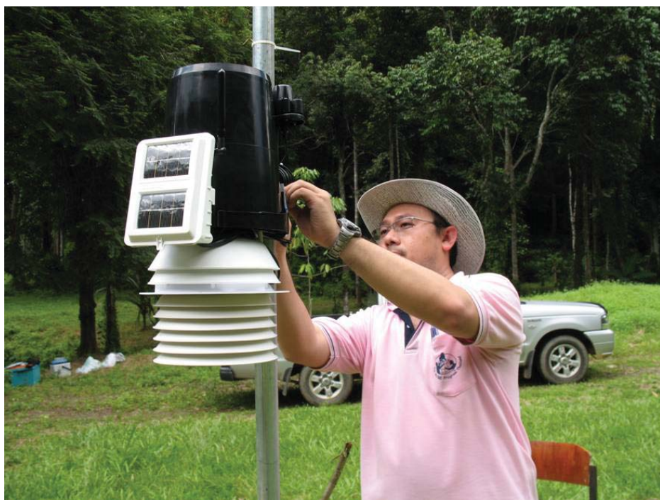
การติดตั้งเครื่องตรวจวัดอากาศอัตโนมัติ
