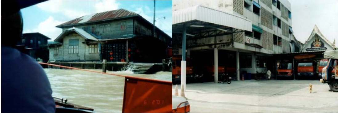
ภาพโกดังร้านเข้าเด็กซึ่งริมคลองบางหลวงเดิมคือไปรษณีย์ตลาดพลู สถานีตำรวจดับเพลิงตลาดพลู
