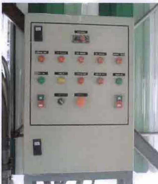
ภาพที่ 3.10 แสดงตู้ควบคุม การทำงาน และชุดควบคุมอุณหภูมิของชุดคอนเดนเซอร์
