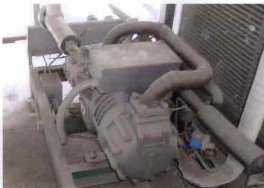
ภาพที่ 3.11 แสดงชุดคอนเดนเซอร์ พร้อมปั๊มสุญญากาศ
