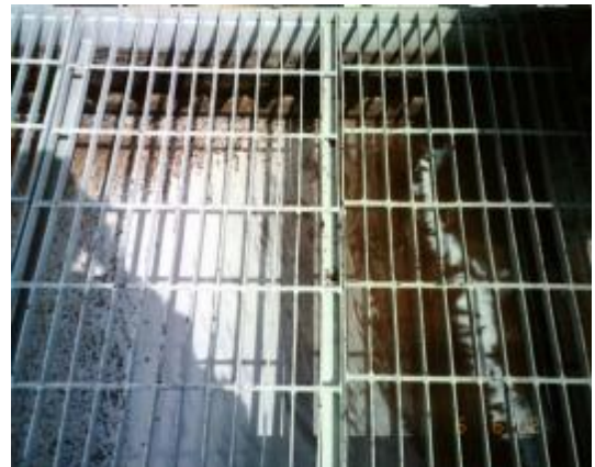
รูปที่ น.2 ตะกอน lacquer ที่ปนเปื้อนในน้ำ
