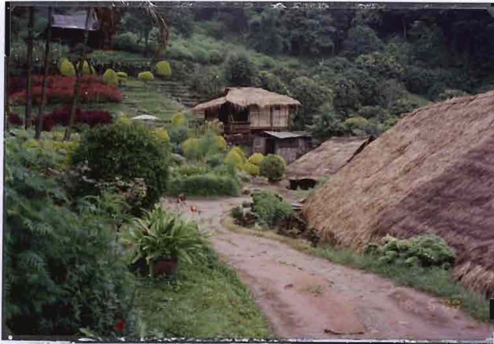
ภาพที่ 59 ภาพอาคารต่าง ๆ หลังการซ่อมแซม
