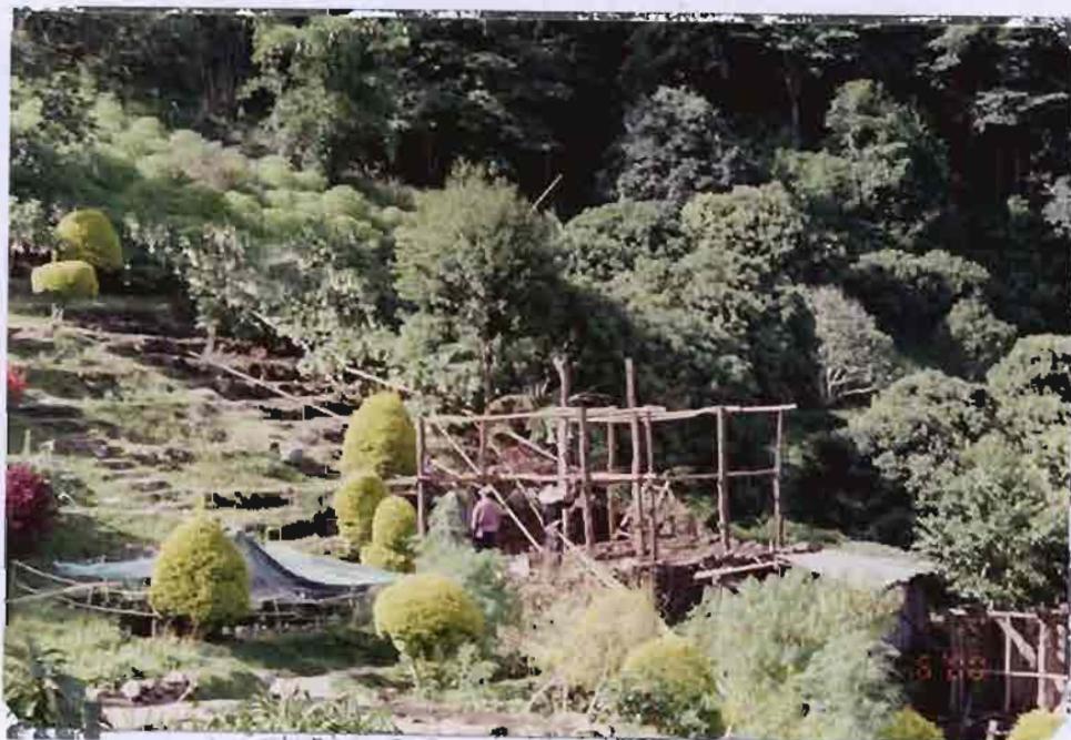
ภาพที่ 58 ภาพการซ่อมแซมโมเดลบ้านกะเหรี่ยง
