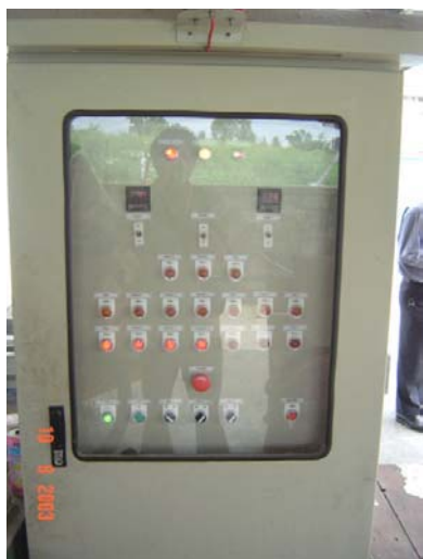
รูปที่ 11.7 ตู้ควบคุมและแสดงสถานการณ์ทำงาน
