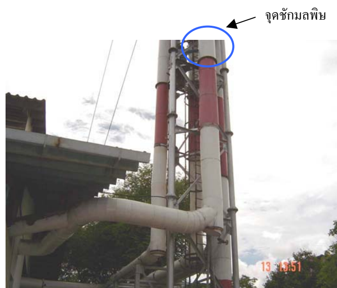
รูปที่ 7.10 ปล่องสำหรับระบายก๊าซไอเสียหลัก
