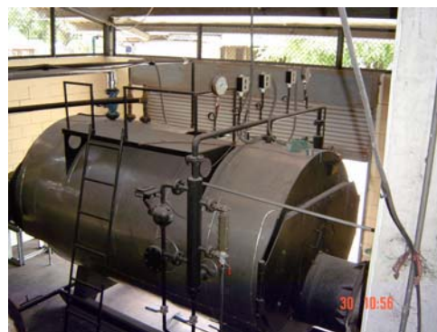
รูปที่ 7.14 boiler ที่รับไอร้อนจากห้องเผาไหม้ที่ 2
