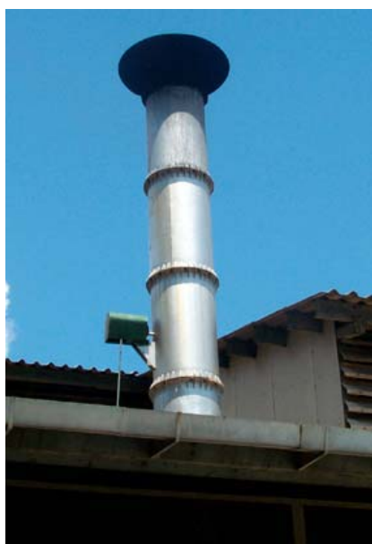
รูปที่ 7.9 ปล่องสำหรับระบายก๊าซไอเสียฉุกเฉิน
