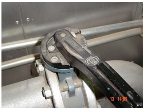
รูปที่ 7.7 วาล์วปรับปริมาณอากาศ ที่ป้อนเข้าห้องเผา
