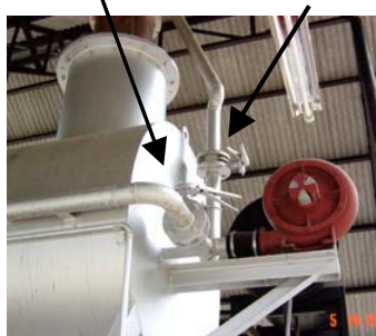
รูปที่ 8.6 พัดลมจ่ายอากาศ ห้องเผาไหม้ที่ 2
