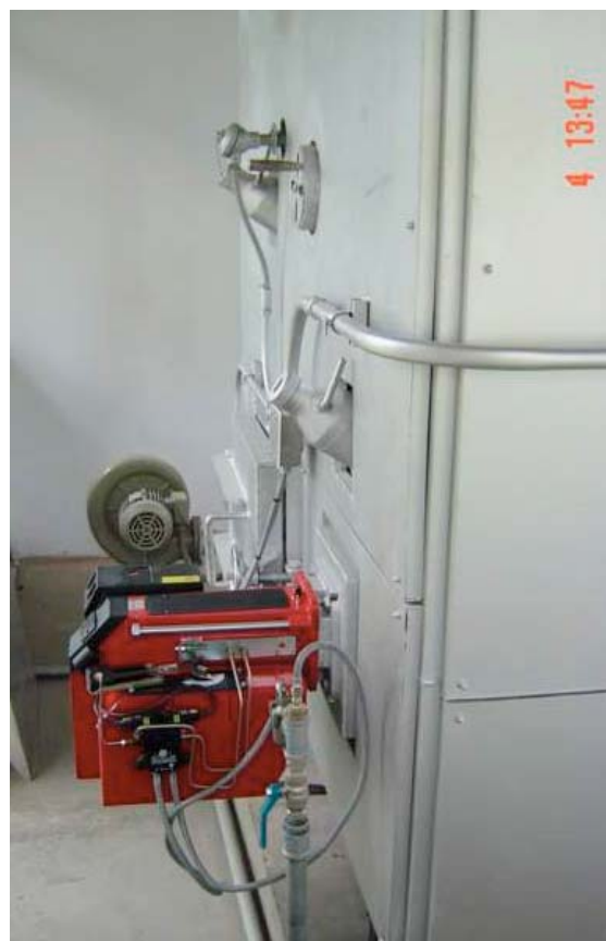
รูปที่ 9.5 หัวเผาของห้องเผาไหม้ที่ 2 (540 kW)
