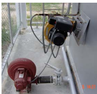
รูปที่ 8.5 หัวเผา,พัดลมจ่ายอากาศ ห้องเผาไหม้ที่ 1
