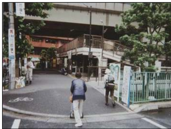
รูปที่ 4.29 การปรับระดับทางเท้าให้ลาดลง
