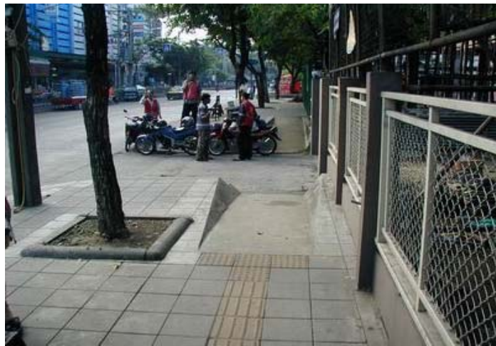
รูปที่ 4.23 ทางลาดสำหรับคนเดินเท้าและผู้จักรยาน
