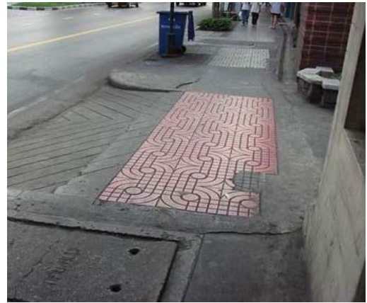
รูปที่ 4.24 การยกระดับถนนและจัดทางลาดสำหรับรถยนต์ ถนนพหลโยธิน
