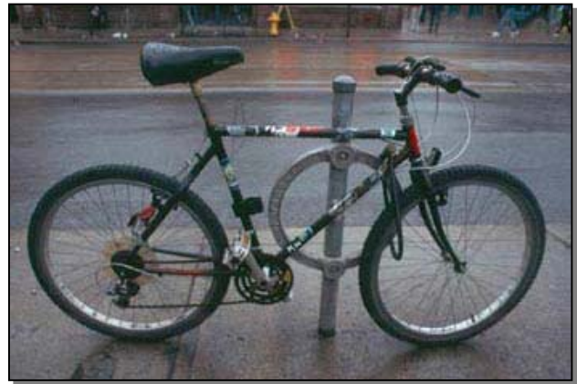
รูปที่ 4.55 ที่จอดจักรยานแบบยึดกับเสา (www.bicyclinginfo.org)
