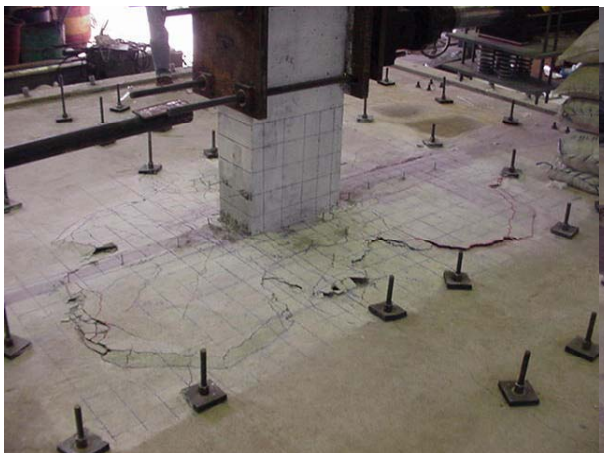
รูป 4.23 ภาพถ่ายการวิบัติเนื่องจากแรงเฉือนทะลุ
