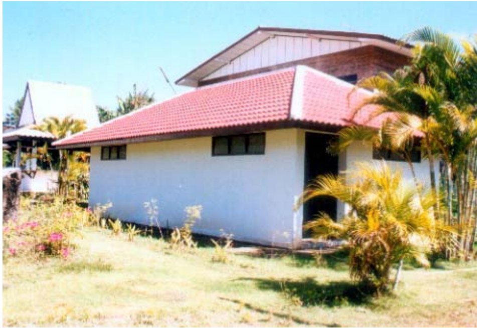
ภาพ ห้องน้ำที่ใช้การไม่ได้ของศูนย์วิจัยตราเพชรฯ ชุมชนผู้ไทบ้านโพธิ์เนื่องจากก่อสร้างในบริเวณที่ลุ่ม น้ำท่วมถึงในฤดูฝน
