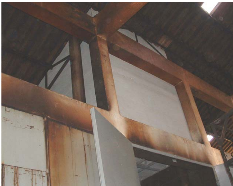
รูปที่ 7.22 ด้านบนรอบห้องรมยางที่ทำการปรับปรุงแล้ว
