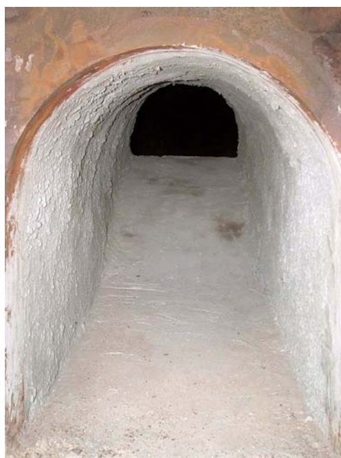
รูปที่ 7.27 เตาเผาฟีนที่ทำการปรับปรุงแล้ว
