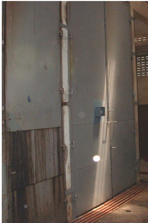
รูปที่ 7.21 ประตูห้องรมยางที่ทำการปรับปรุงแล้ว
