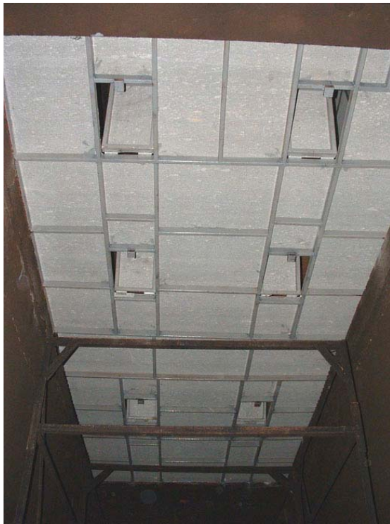
รูปที่ 7.23 เพดานห้องรมยางที่ทำการปรับปรุงแล้วแสดงตำแหน่งบานระบายความชื้น
