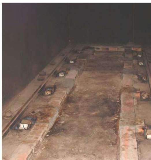
รูปที่ 7.25 พื้นห้องรมยางที่ทำการปรับปรุงแล้วโดยแสดงการติดตั้งอุปกรณ์ดักจับอนุภาค
