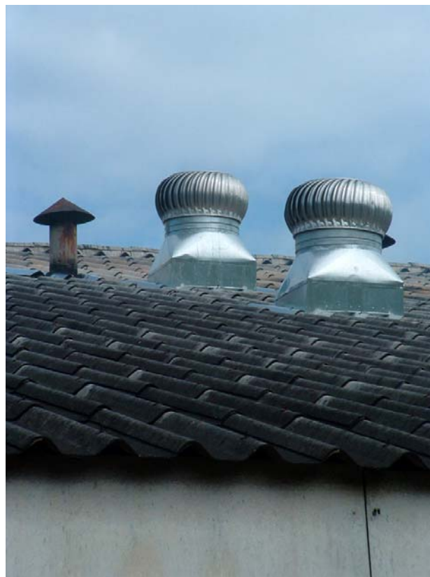
รูปที่ 7.24 พัดลมดูดอากาศบนหลังคาห้องรมที่ปรับปรุงแล้ว
