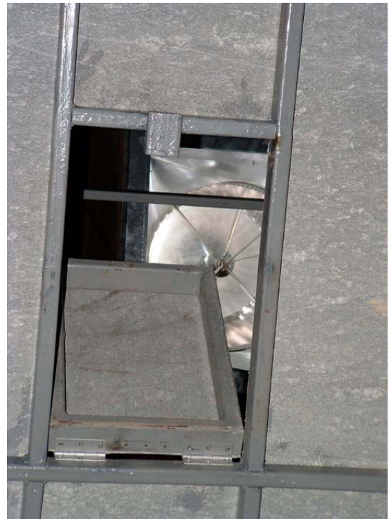
รูปที่ 7.23 เพดานห้องรมยางที่ทำการปรับปรุงแล้วแสดงตำแหน่งบานระบายความชื้น
