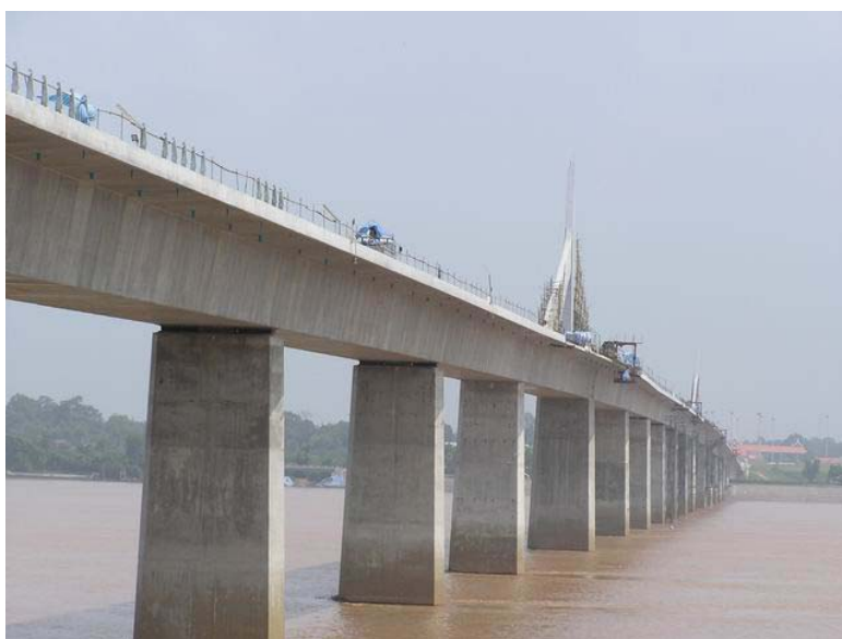
รูปที่ 4-3 สะพานข้ามแม่น้ำ โขงที่ จ.มุกดาหาร
