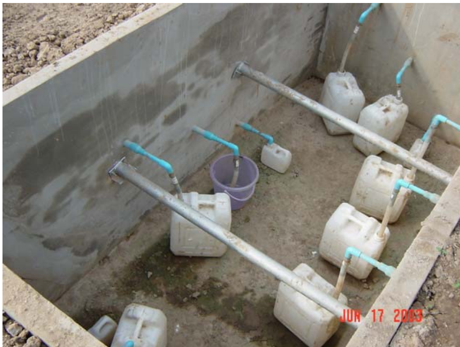
ฉ. ถังรับน้ำซึมใต้แปลงผัก 2
