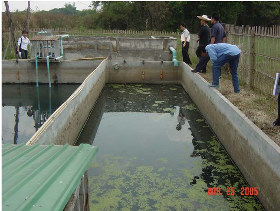
ก. ถังตกตะกอนขั้นต้นและถังเก็บน้ำ RW, PE
