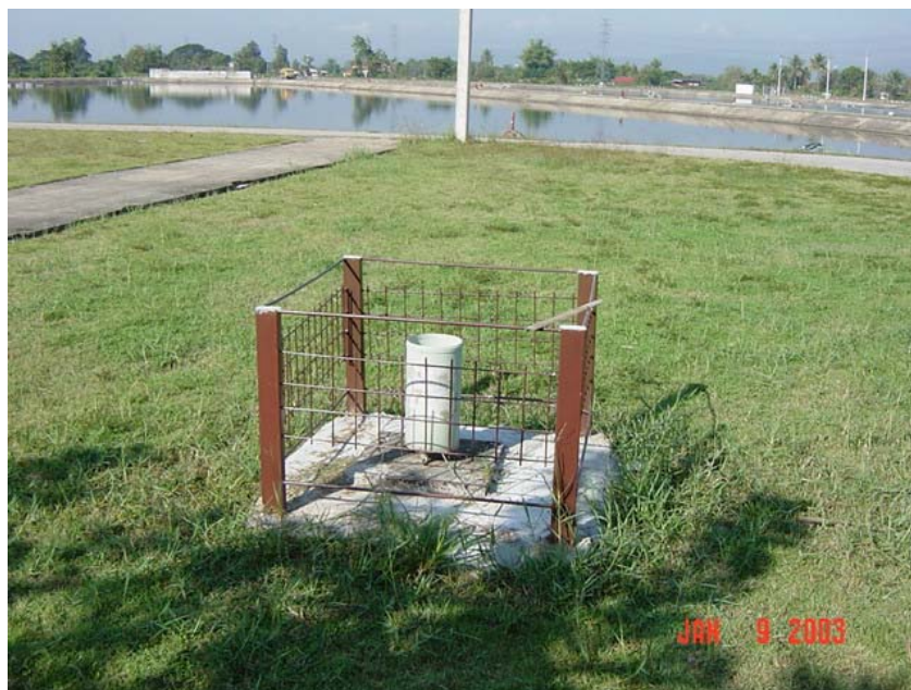
รูปที่ 1-10 เครื่องวัดน้ำฝนในบริเวณโรงบำบัดน้ำเสียเทศบาลนครเชียงใหม่
