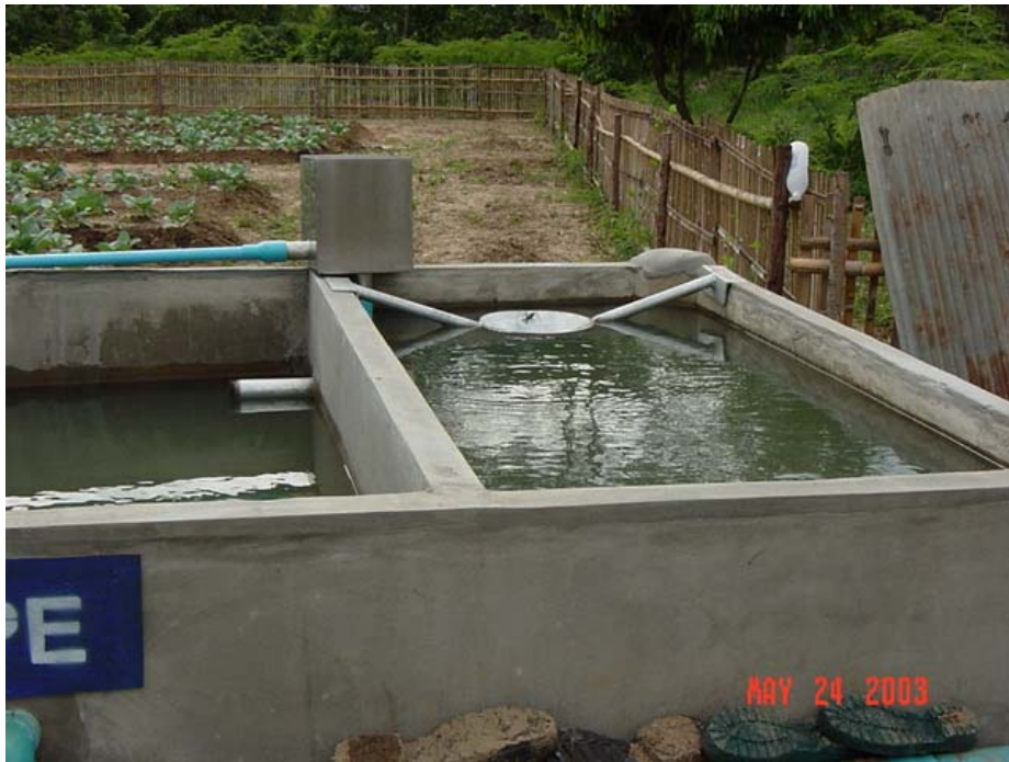
ก. ถังตกตะกอนขั้นต้นและ Weir Box 1
