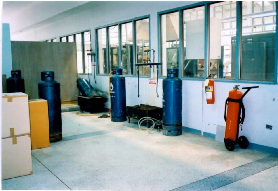
รูปที่ 12 แสดงภาพการวางถังแก๊สที่ใช้สำหรับเตาเผา
