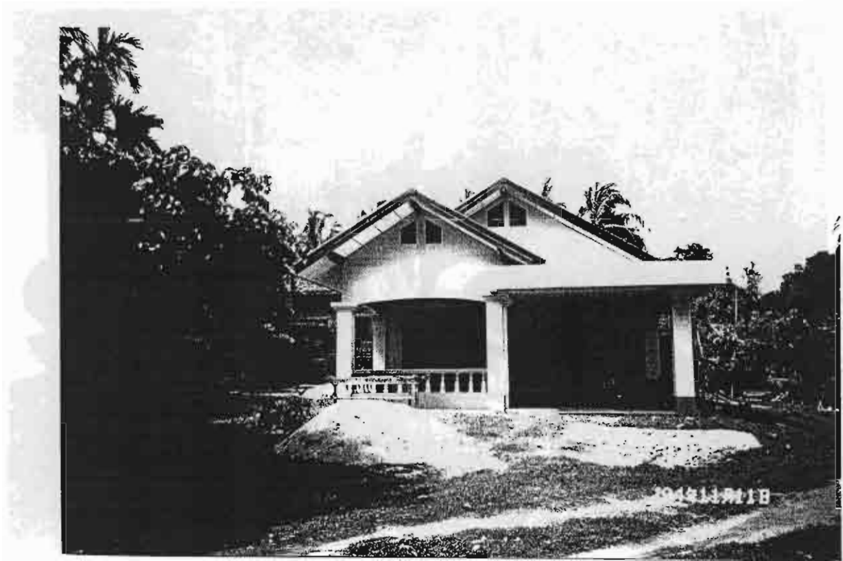
บ้านใหม่ของสมาชิกที่นำหัวกรงนกมาแลกกับวัสดุก่อสร้าง
