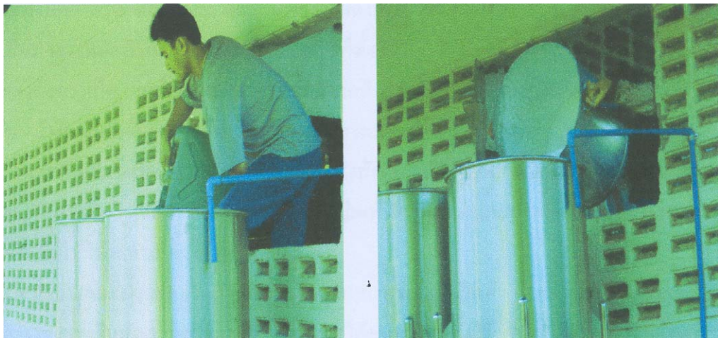
เติมน้ำกรดลงถังพักน้ำกรด
