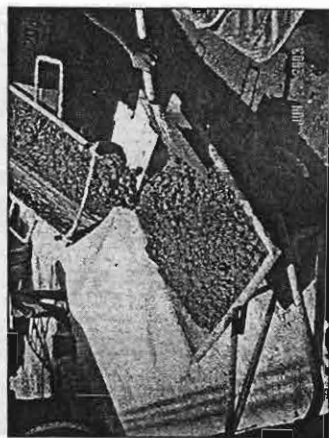
(ฉ) การเทคอนกรีตออกจากรถผสม
