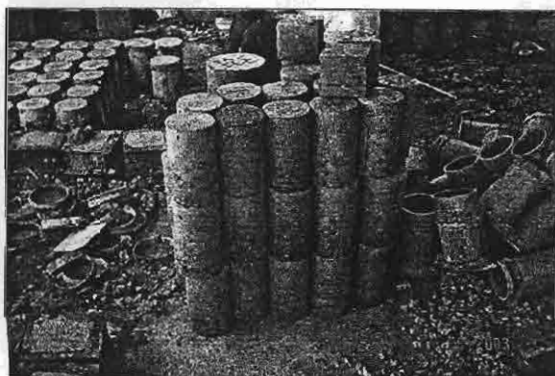
ภาพที่ จ.5.9 คอนกรีตหลังจากการถอดแบบ
