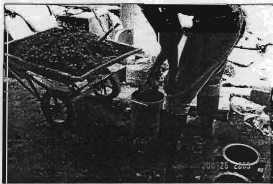
ภาพที่ จ.6.2 การใส่คอนกรีตลงในถังทดสอบ
