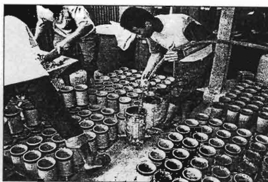
ภาพที่ จ.5.8 การบรรจุคอนกรีตลงในแบบหล่อ
