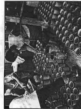
(ด) การใส่คอนกรีตลงในแบบหล่อ
