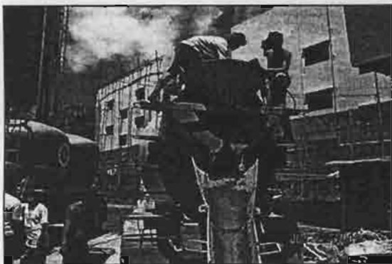
ภาพที่ จ.5.7 การเติมน้ำในรตผสม คอนกรีตเพื่อให้คอนกรีตมีค่าการยุบตัว (Slump) ของคอนกรีตได้ตามกำหนดไว้
