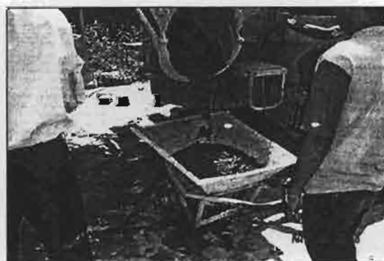
ภาพที่ จ.5.6 การขนถ่ายคอนกรีตผสมเสร็จ ลงจากรถโม
