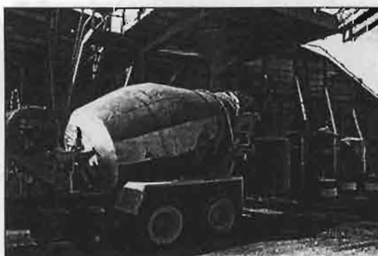
ภาพที่ จ.5.5 การบรรจุคอนกรีตผสมเสร็จลงรถโม
