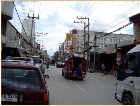
ภาพที่ 4.84 สภาพถนนและทางเท้าบนถนนช้างคลาน
