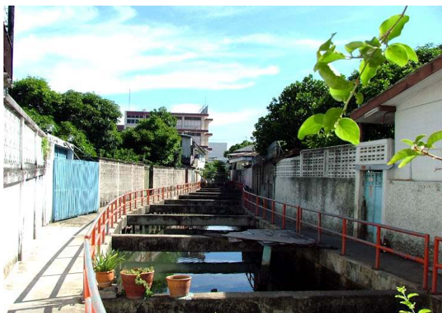
ภาพที่ 4-15 สภาพปัจจุบัน คลอง และคาน้ำยันตลิ่งและทางเดินริมคลอง
