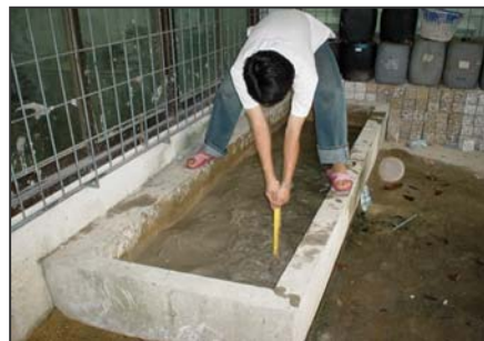
ภาพที่ 4.5 การกวนน้ำสลัดจ์ในบ่อพัก
