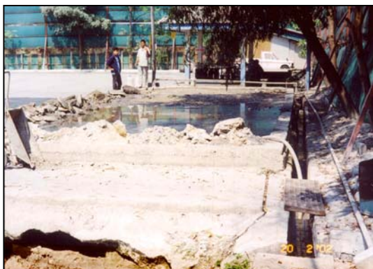
ภาพที่ จ.3 บ่อทิ้งกากคอนกรีต
