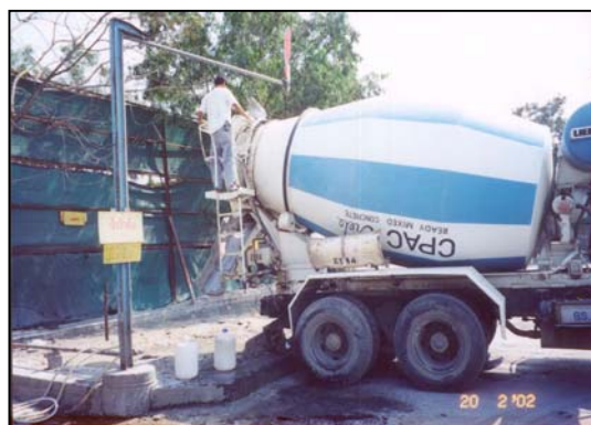
ภาพที่ จ.2 การล้างโม้ของรถคอนกรีตผสมเสร็จ
