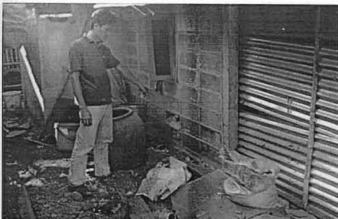
ภาพประกอบที่ 14 สภาพผนังบ้านที่บ้านโนนค้อ เกิดการผุกร่อนจนทะลุ
