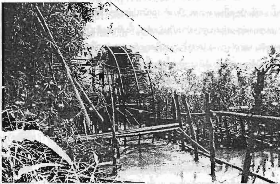
พัดหรือระหัดวิดน้ำ ภูมิปัญญาท้องถิ่นวัฒนธรรมลุ่มแม่น้ำห่มัน ปัจจุบันชาวบ้านยังคงใช้พัดนี้อยู่ที่บ้านนาเวียงและนาหอ
